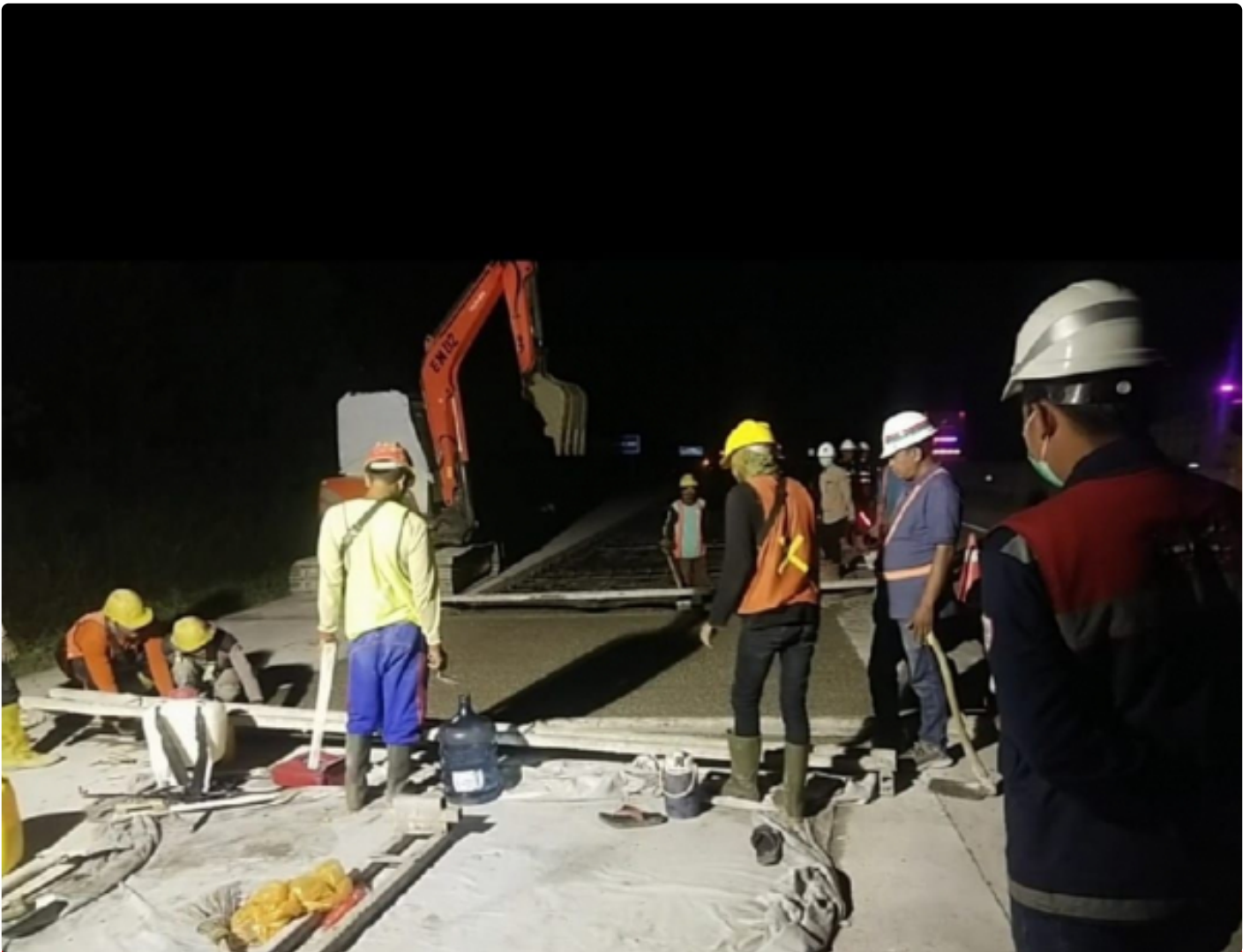
PT HKI Perbaikan Tol Terbanggi Kayu Agung
